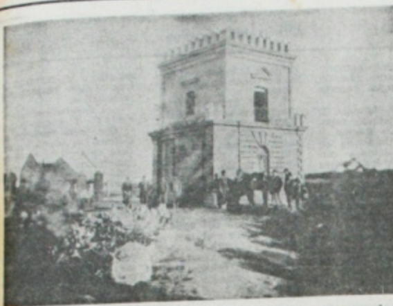
La casa del coronel Levalle en la por entonces nueva población de Carhué.
